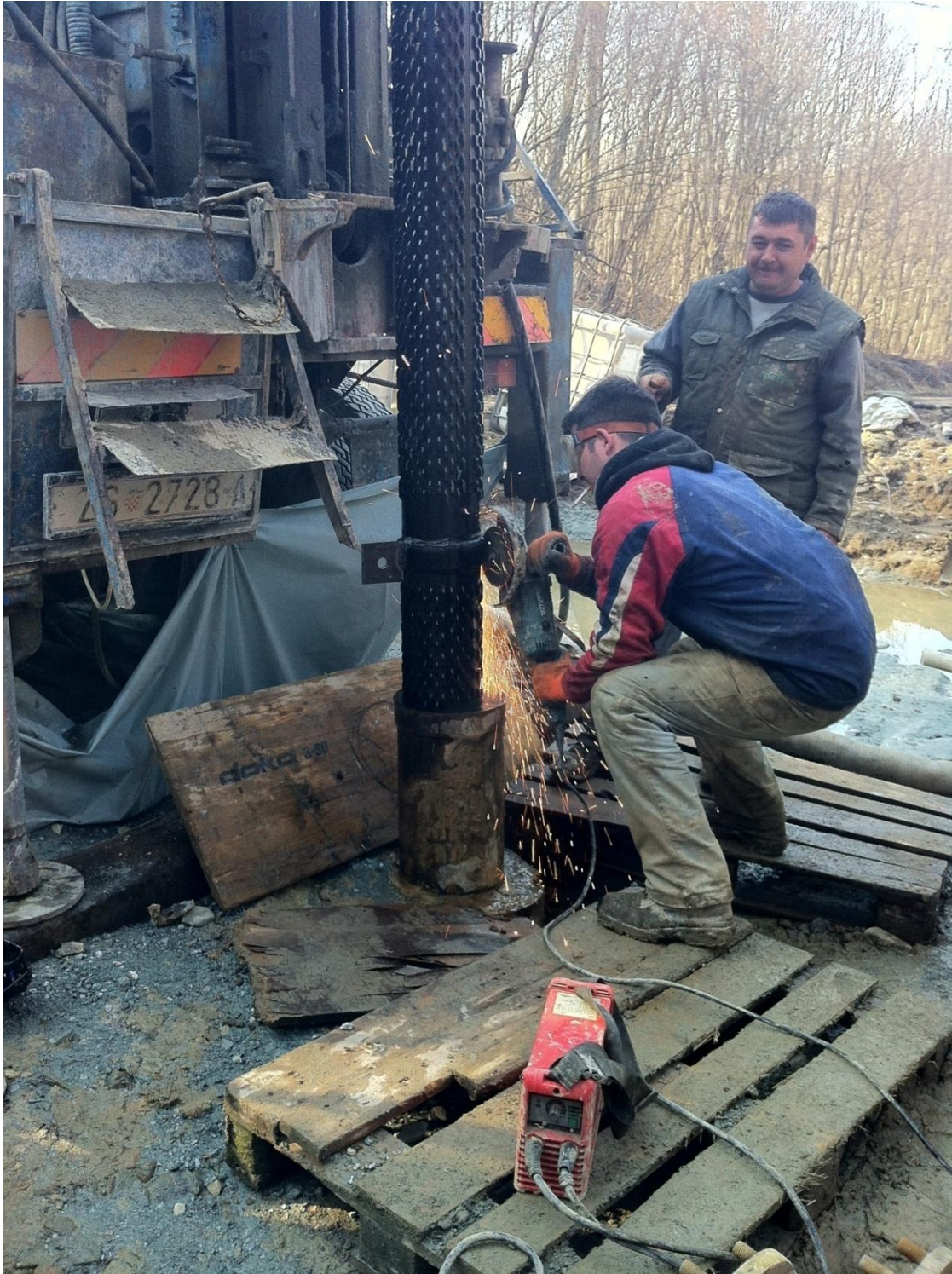
Slika 5-6. Ugradnja sita.
