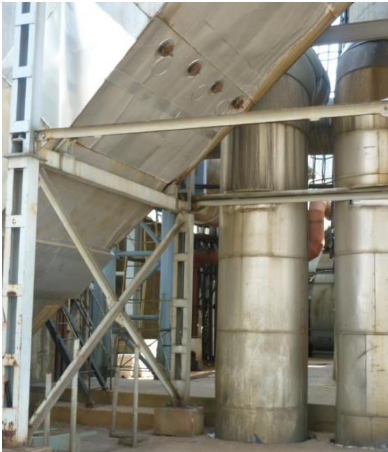
Slika 4-18. Mjerno mjesto (lijevo) i mjerni priključci (desno) kotla K3 (EKONERG d.o.o., 2015).
