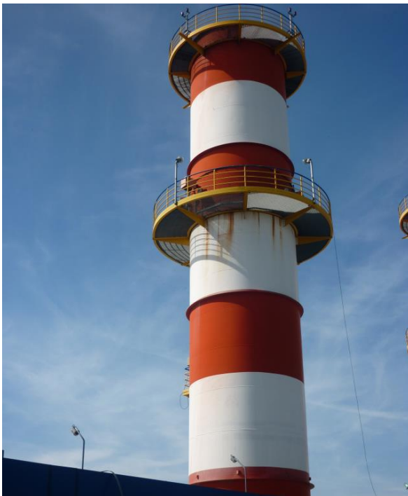
Slika 4-19. Mjerno mjesto (lijevo) i mjerni priključci (desno) plinskih turbina (EKONERG d.o.o., 2015).
