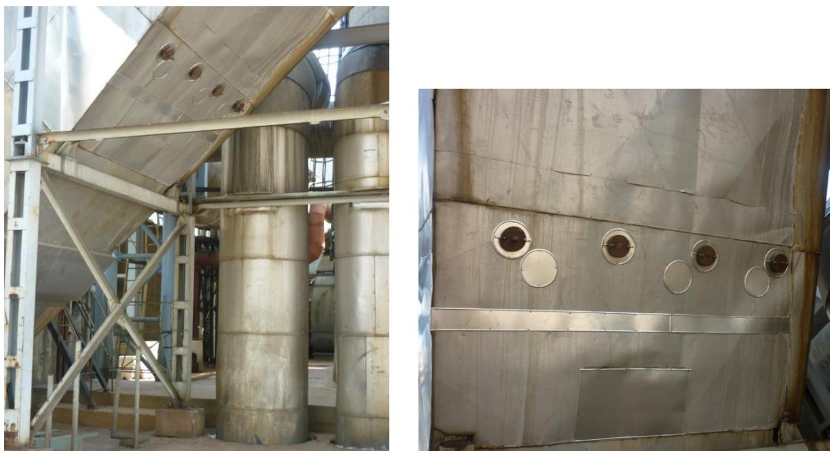
Slika 4-18. Mjerno mjesto (lijevo) i mjerni priključci (desno) kotla K3 (EKONERG d.o.o., 2015).
