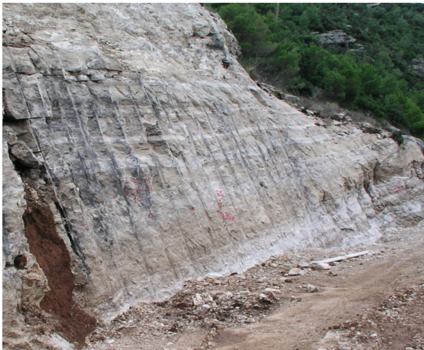
Slika 3-11. Završna kosina izvedena konturnim miniranjem (Dobrilović, 2008).
