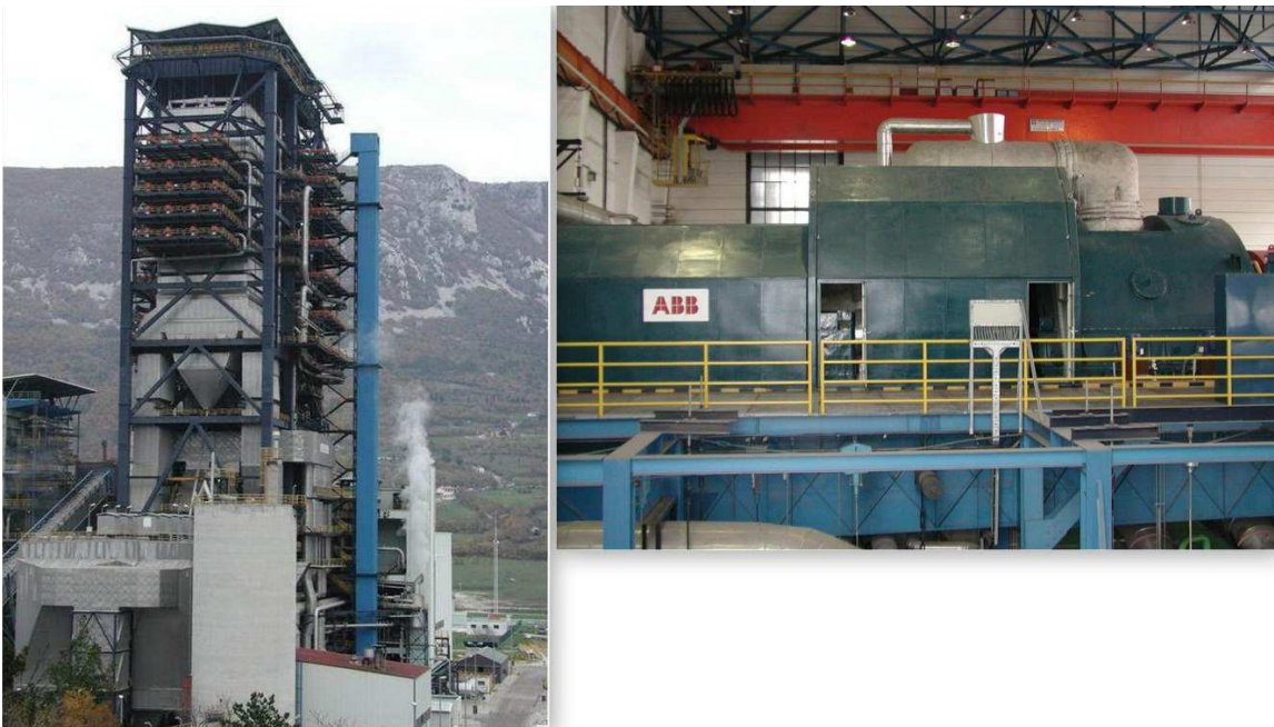
Slika 4-7. Kotao (lijevo) i turbina (desno) TEP 2 (Vukelić, 2013.)
