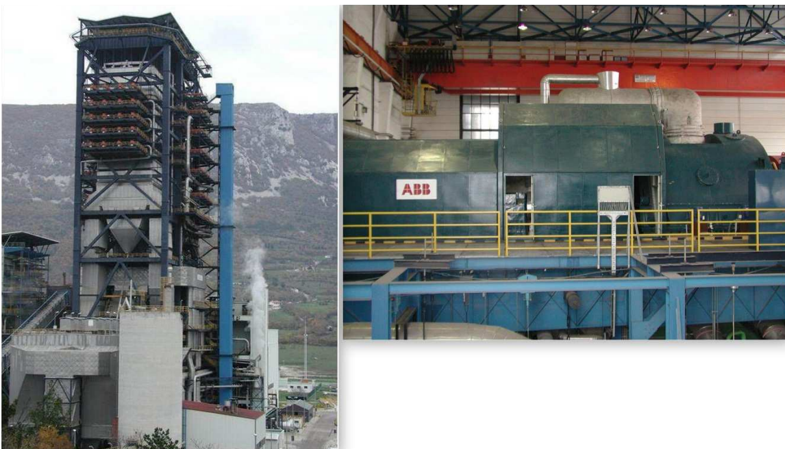
Slika 4-7. Kotao (lijevo) i turbina (desno) TEP 2 (Vukelić, 2013.)
