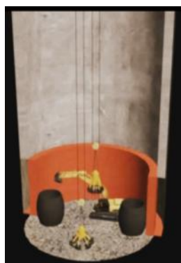
Utovar i transport odminiranog materijala
