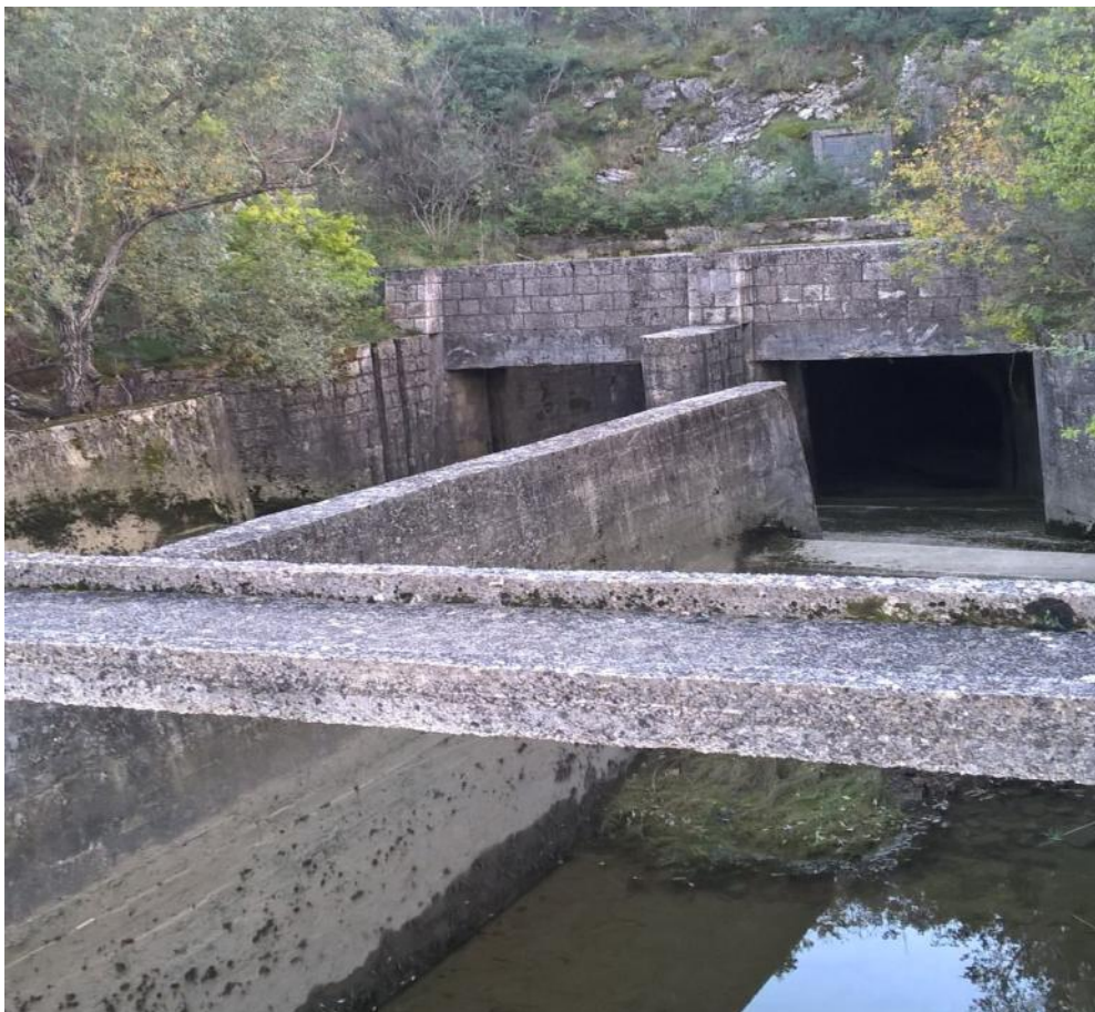
Slika 2-2. Sjeverna strana tunela
