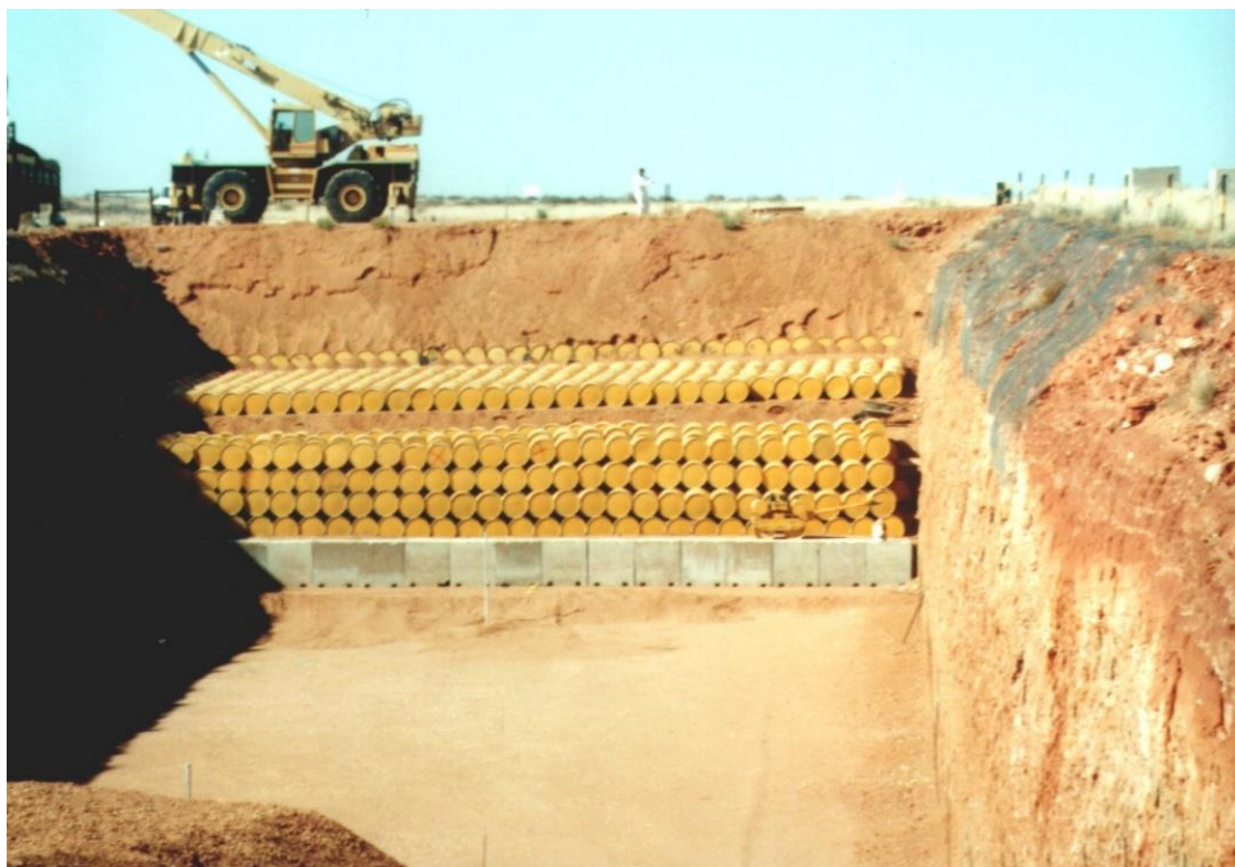
Slika 2-4. Odlagalište otpada Vaalputs za nisko radioaktivni otpad, Južnoafrička Republika (IAEA, 2015)
