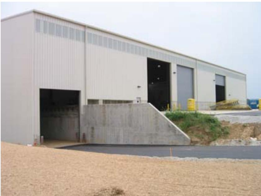
Slika 6-5. Zatvorena srednja PS denivelirana u pola etaže s jednim pretovarnim mjestom (Hidroing, 2014)
