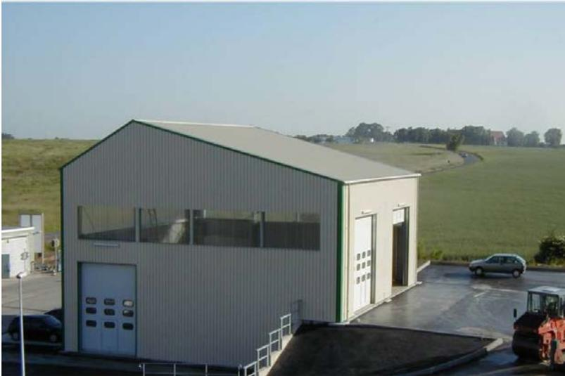
Slika 6-4. Zatvorena mala PS denivelirana u pola etaže s jednim pretovarnim mjestom (Hidroing, 2014)
