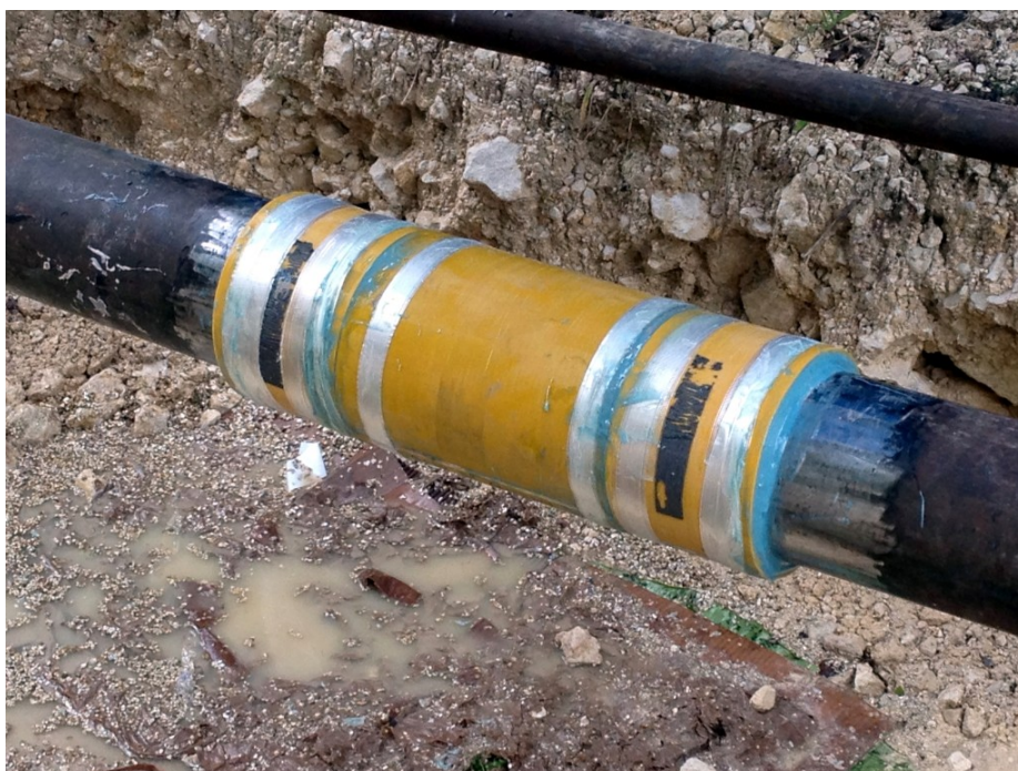
Slika 7-3. "Clock Spring" obujmica ( www.pipeserv.gr , 2016)
