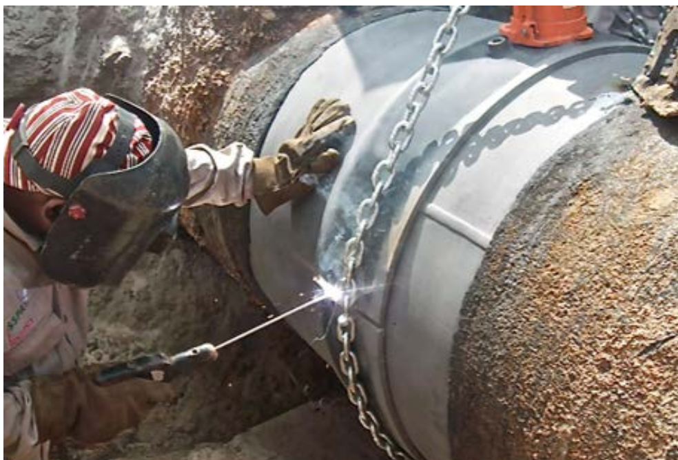
Slika 7-2. Čelična obujmica Tip B (www.pipeserv.gr, 2016)
