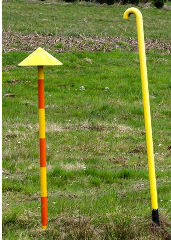
Slika 6-1. Ozraka trase (trasirka) i kontrolna cijev (lula) (www.mzoip.hr, 2015)
