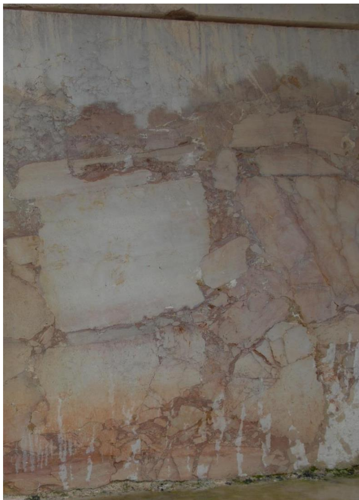
Slika 4-6. Istražna galerija izrađena u prvom produktivnom sloju (karbonatne breče)
