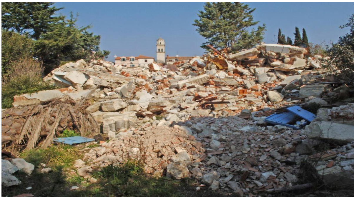
Slika 2-1. Prikaz „divljeg“ odlagališta građevinskog otpada
