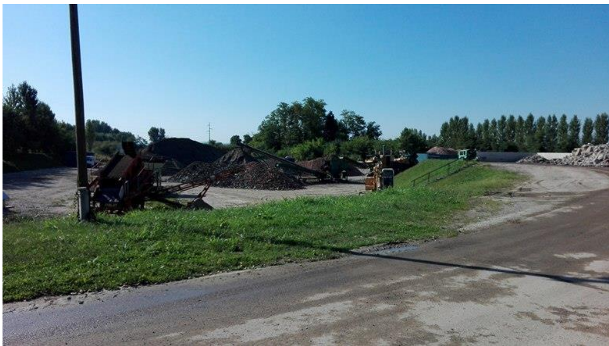
Slika 4-1. Teren i postrojenje reciklažnog dvorišta „Mišić“
