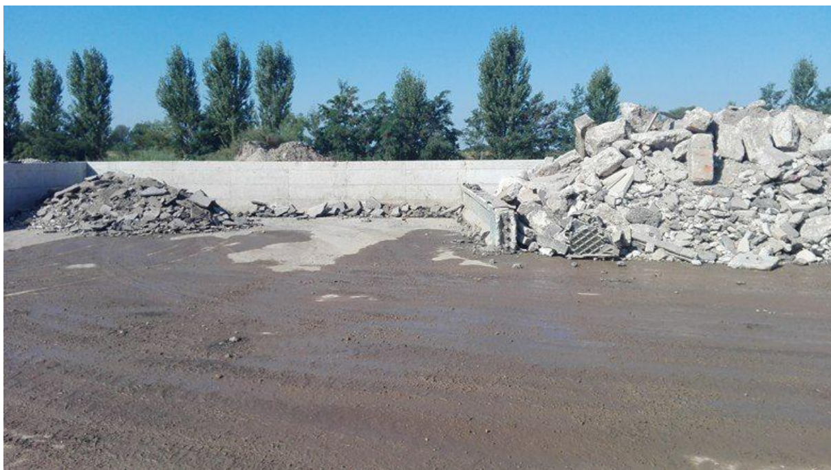
Slika 4-3. Razdvajanje građevinskog otpada na vodonepropusnom platou (lijevo je asfaltni lom, dok je u desnom boksu betonski lom)
