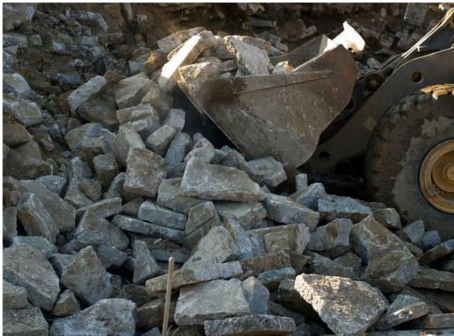
**Slika 4-7.** Utovar betonske šute bagerom sa vodonepropusnog platoa
