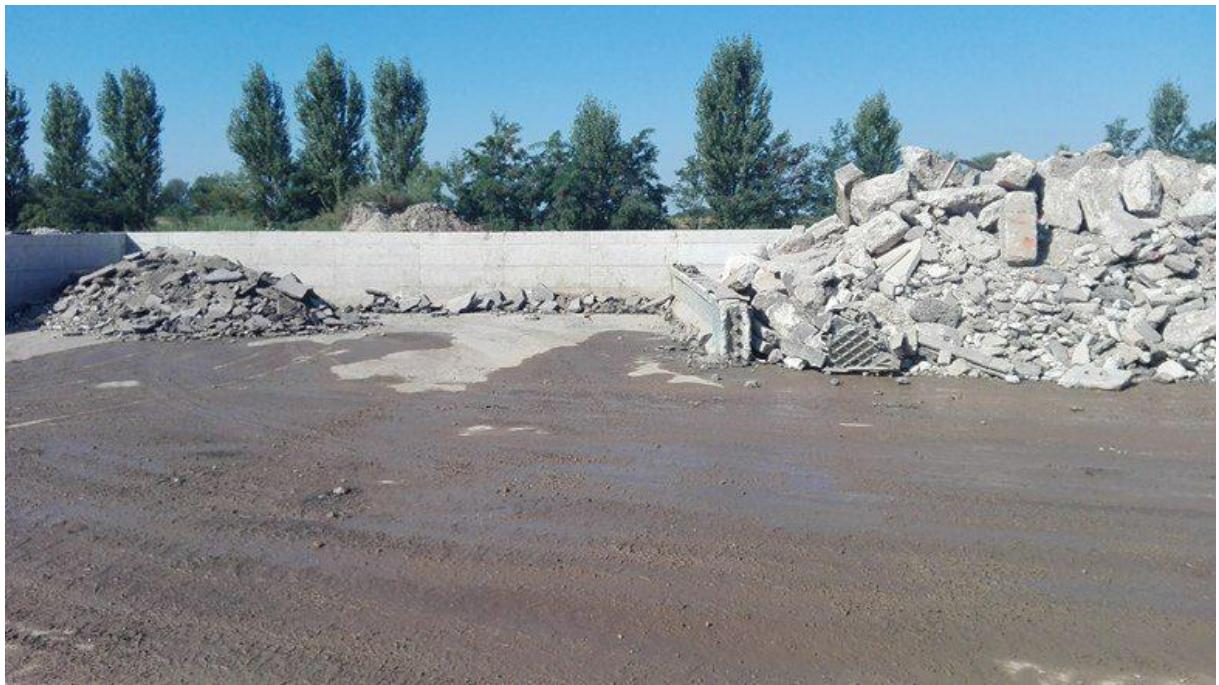
**Slika 4-3.** Razdvajanje građevinskog otpada na vodonepropusnom platou (lijevo je asfaltni lom, dok je u desnom boksu betonski lom)
