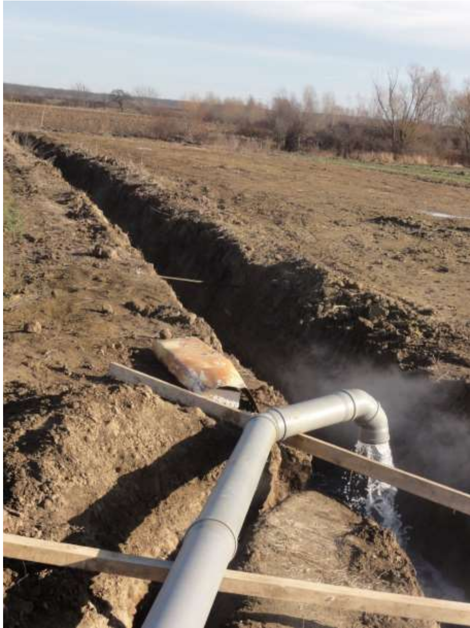
Slika 5-1. Ispuštanje vode u melioracijski kanal
