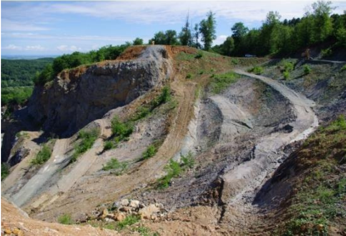
Slika 5-6. Tehnička sanacija i biološka rekultivacija (Vrkljan 2013)
