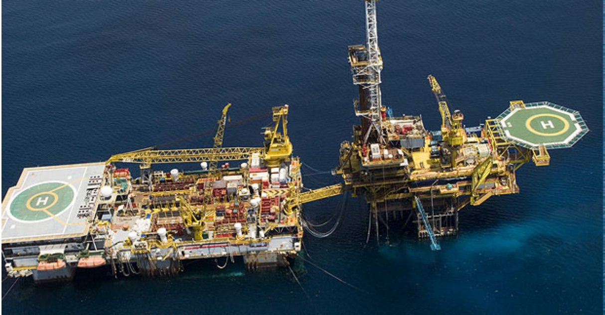
Slika 2-16. Tender platforma (lijevo) povezana s bušaćom platformom ( www.drillingformulas.com )
