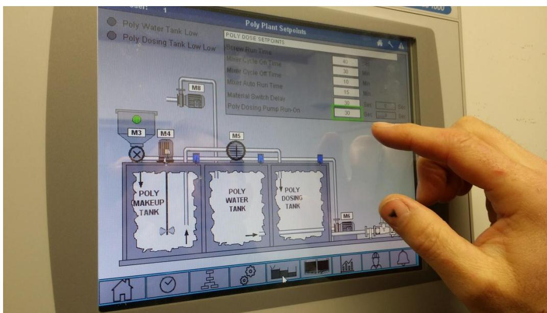
Slika 3-8. Zaslon upravljačke jedinice stanice za pripremu flokulanta
