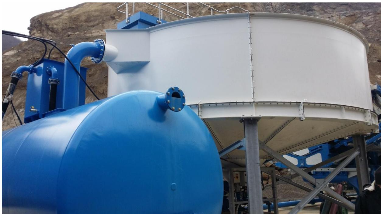
Slika 3-10. Sedimentacijski bazen i spremnik obrađene tehnološke vode
