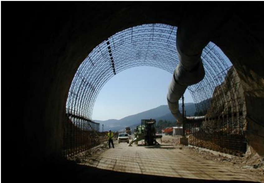
Slika 2-3. Tunel „Plasina“ (GI grupa d.o.o., 2002)
