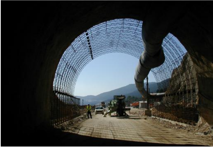
Slika 2-3. Tunel „Plasina“ (GI grupa d.o.o., 2002)
