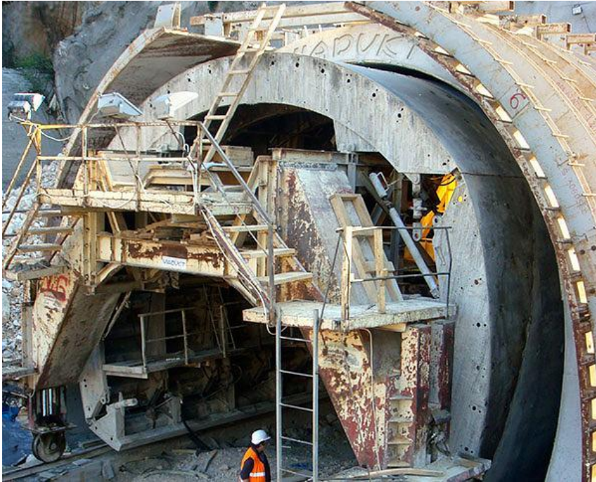
Slika 2-4. Tunel „Škurinje II“ (Viadukt d.d., 2008)
