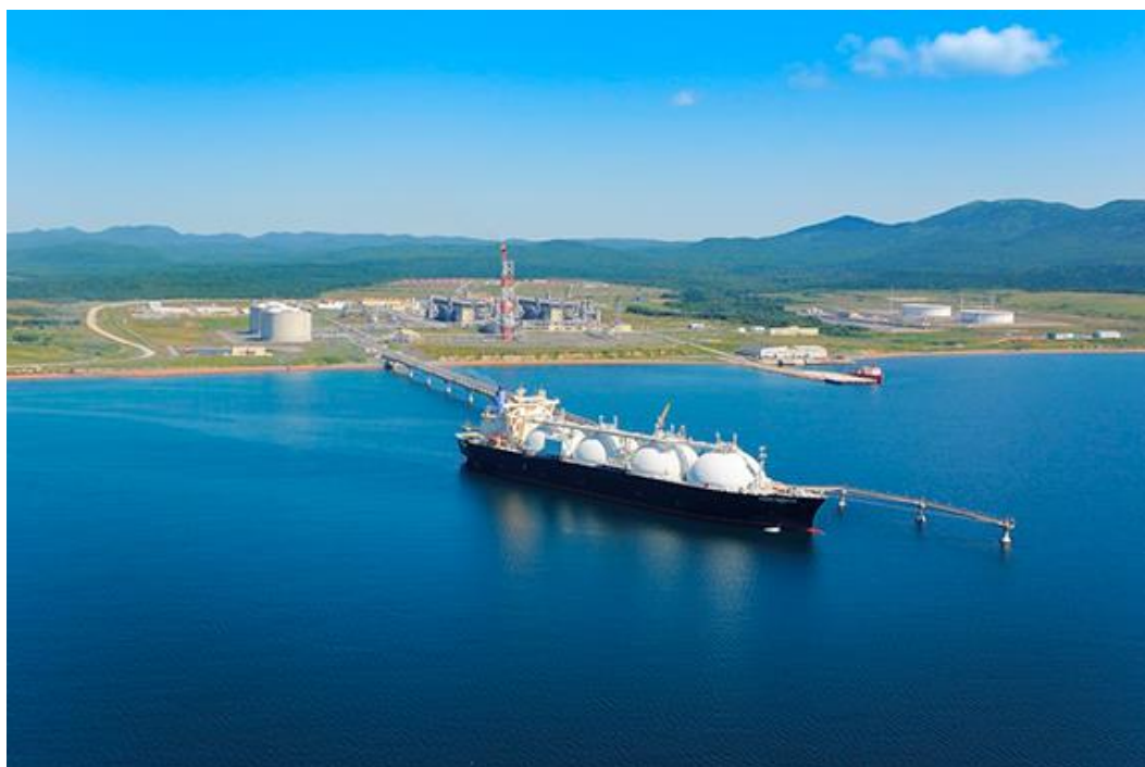
Slika 5-3. Sakhalin II postrojenje za UPP ( www.sakhalinenergy.ru )
