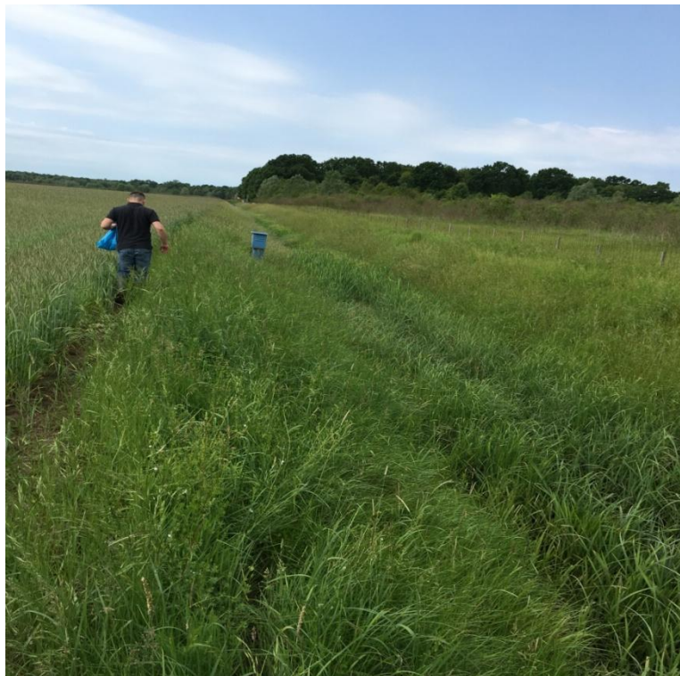
Slika 3.6. Odvodni kanal na melioracijskog pokusnom polju „Jelenščak“, Kutina (foto: Al Ahmed, 2016).
