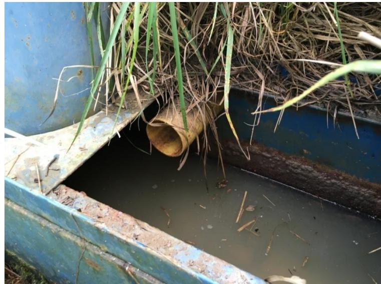
**Slika 3.7.** Izljev vode iz drenažne cijevi u melioracijski kanal (foto: Al Ahmed, 2016).
