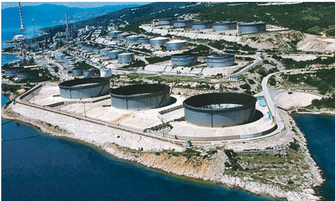
Slika 4-1. Rafinerija nafte Rijeka (Pleše, 2013)
