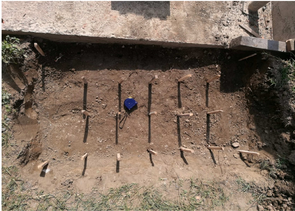
Slika 6-3 Prikaz rastera s iskolčnim točkama na terenu
