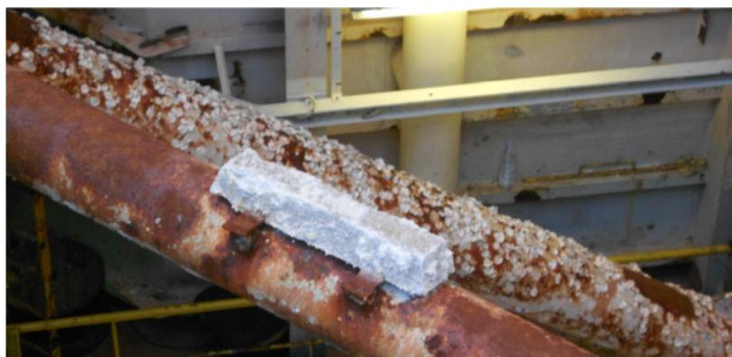
Slika 5-12. Iskorištene žrtvene anode (Crosco, 2015c)
