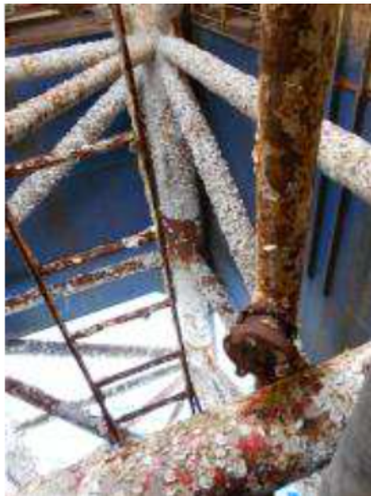
Slika 5-11. Dotrajali mlazni cjevovod (Crosco, 2015c)
