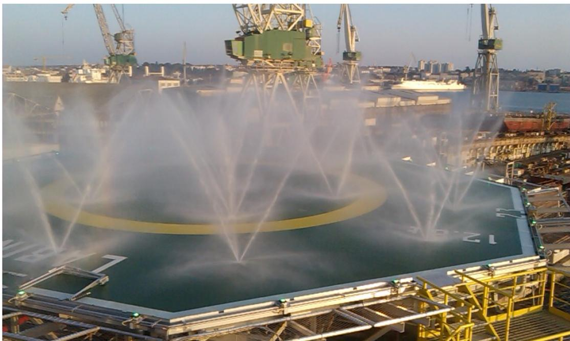
Slika 5-6. Novi sustav zaštite od požara na helikopterskoj palubi (Crosco, 2015c)
