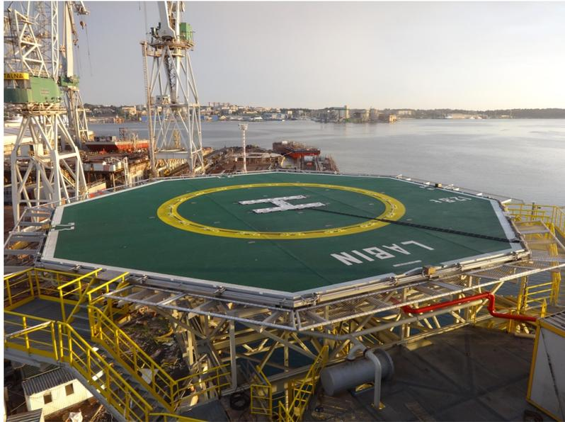
Slika 5-5. Nova helikopterska paluba (Crosco, 2015c)
