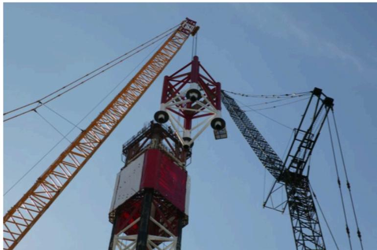
Slika 4-2. Produljenje nogu platforme (Zadravec, 2007)
