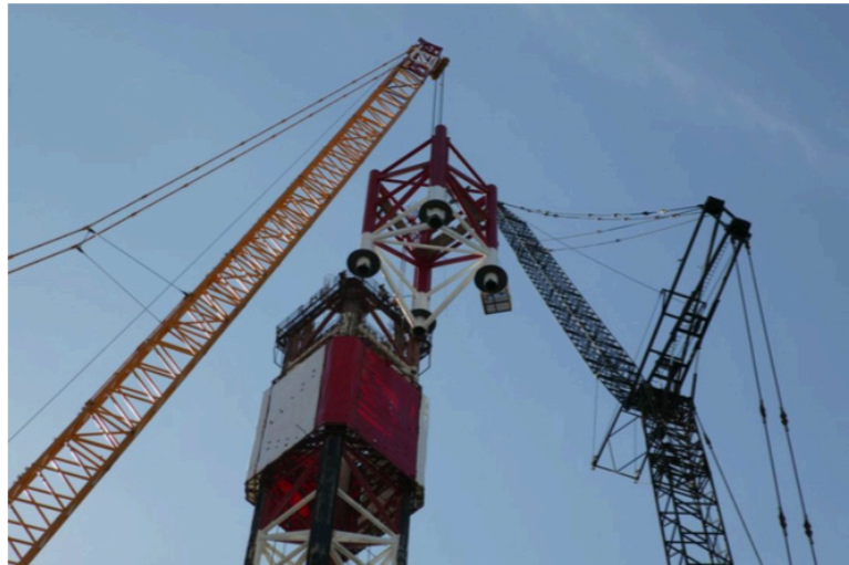
Slika 4-2. Produljenje nogu platforme (Zadravec, 2007)
