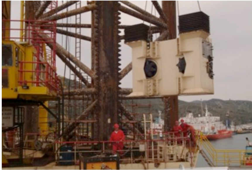
Slika 4-3. Podizanje dodatnog podiznog sustava (Sabljak, 2005)
