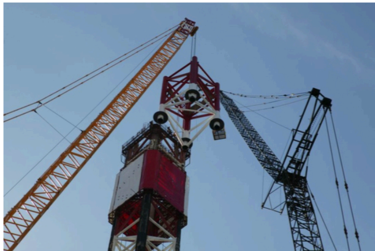
Slika 4-2. Produljenje nogu platforme (Zadravec, 2007)
