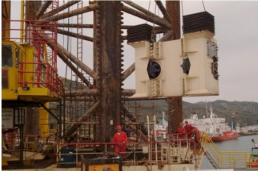
Slika 4-3. Podizanje dodatnog podiznog sustava (Sabljak, 2005)
