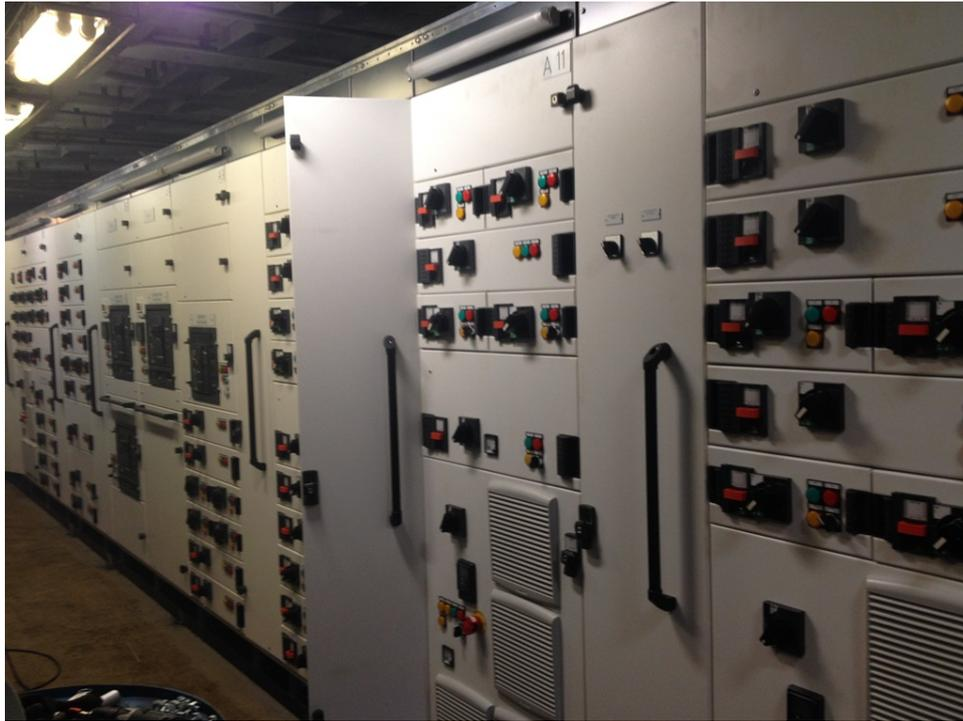
Slika 5-8. Novi glavni sklopni blok nakon ugradnje (Crosco, 2015c)
