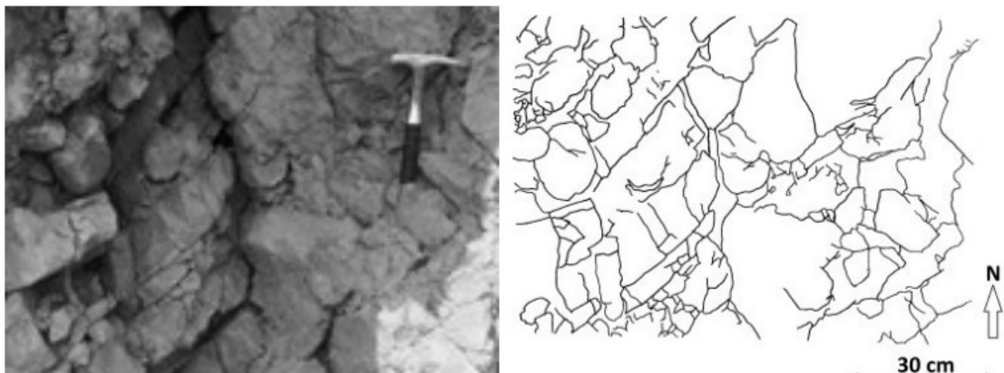
Slika 6-1. Usporedba fotografije izdanka i digitaliziranih trasa pukotina (GUREL et al., 2016).
