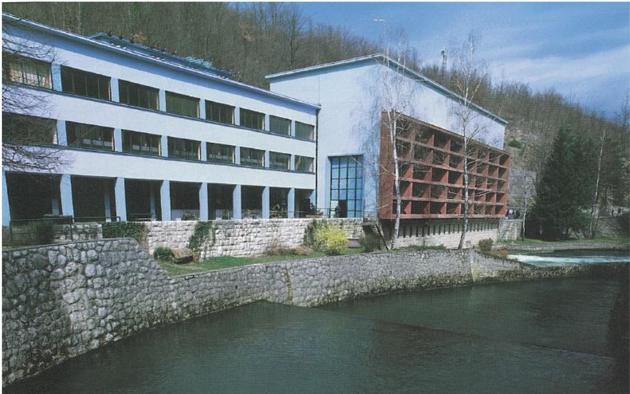
Slika 3.5 Zgrada strojarnice HE Gojak
