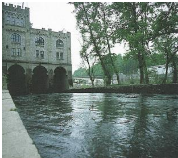
Slika 3.4 Odvodni kanal HE Ozalj I
