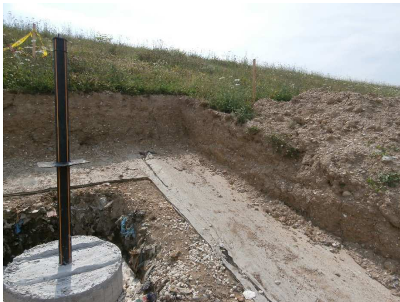
Slika 9-3 Nadsloj iznad istražnog raskopa S20
