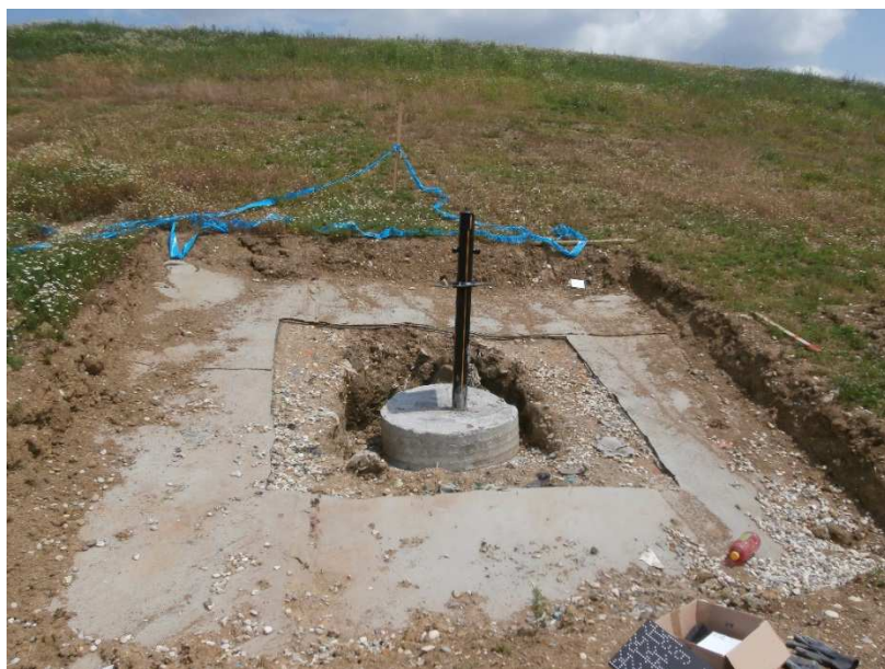
Slika 9-2 Nadsloj iznad istražnog raskopa S16
