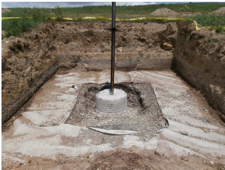
Slika 8-9 Nadsloj iznad istražnog raskopa S2
