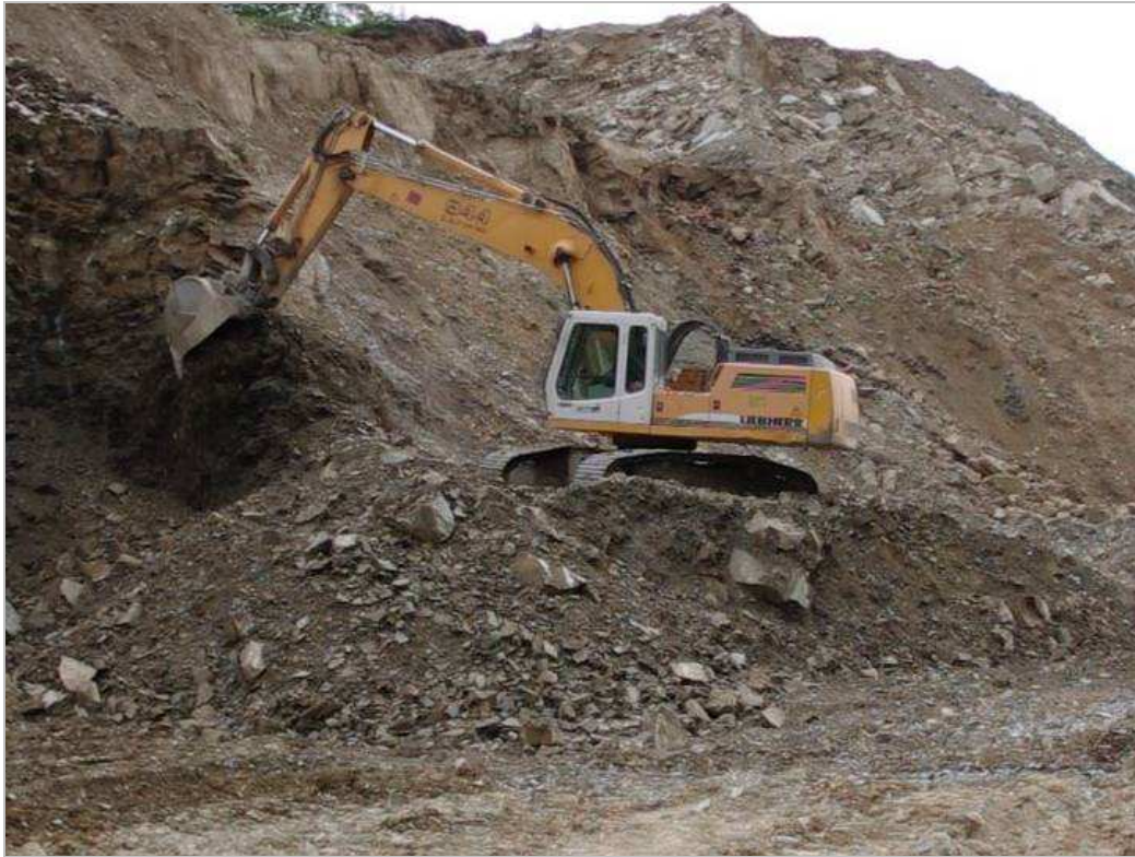
Slika 2.4 Rad bagera na dobivanju otkrivke
