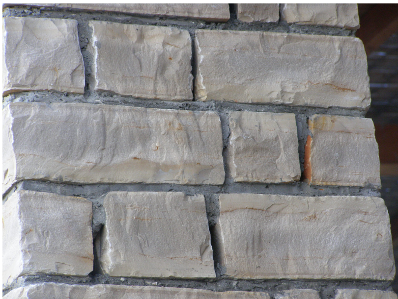
Sl.1.1. Obloženi zid s pločama benkovačkoga kamena obrađenim kao bunja .
