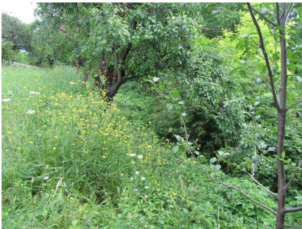
Slika 100 Istočni bok bivšeg iskopa lapora na Kostanjeku, obrasla glavna vlačna pukotina (snimljeno u ljeto 2012. godine)
