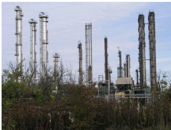
Slika 3.4. Dimnjaci sisačke rafinerije
