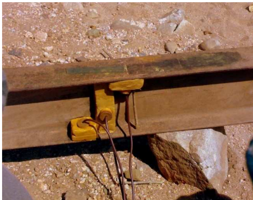
Slika 3-7. Primjena plastičnog eksploziva za rezanje metala
