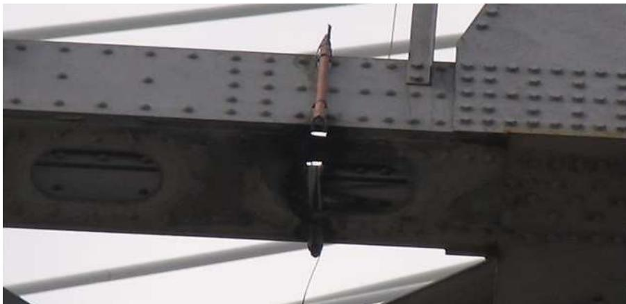
Slika 4-9. Postavljanje linijskih kumulativnih rezača prilikom rušenja mosta
