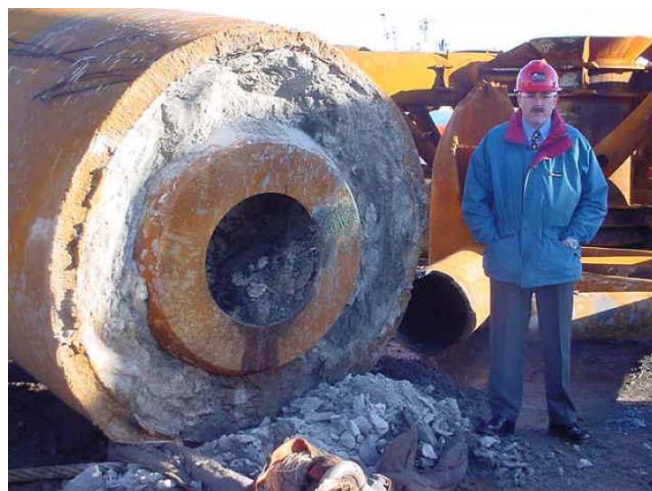
Slika 4-13. Nosivi stup platforme presječen linijskim kumulativnim rezačem
