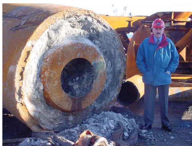
Slika 4-13. Nosivi stup platforme presječen linijskim kumulativnim rezačem
