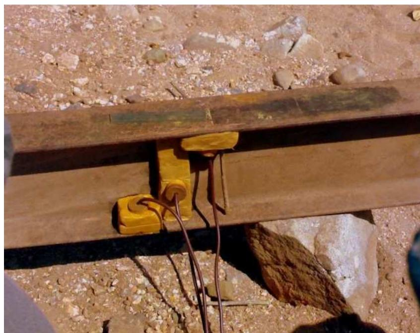
Slika 3-7. Primjena plastičnog eksploziva za rezanje metala
