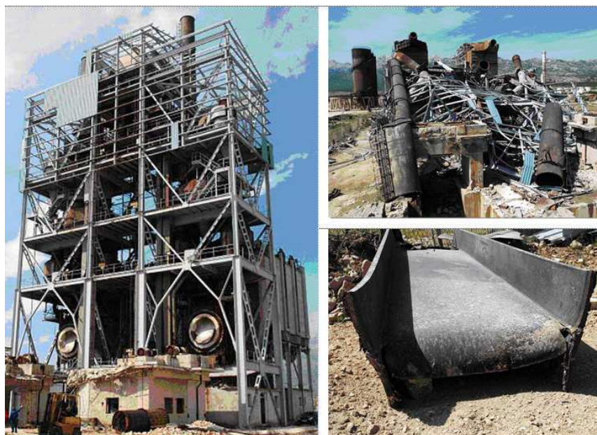
Slika 4-10. Objekt prije rušenja, nakon rušenja i presječeni dio konstrukcije (Sućeska et al. 2005).
