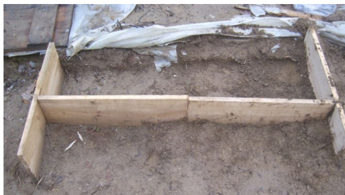
Slika 5.13. Površina aplikacije traser ograđena radi sprječavanja otjecanja traser.
