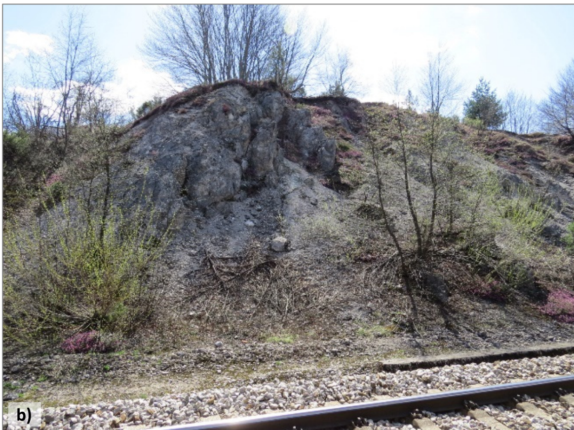
Slika 6-22. IG prospekcija kosine 604-7-D: a) sipar formiran na većem dijelu kosine; b) stijenska masa na kraju kosine
