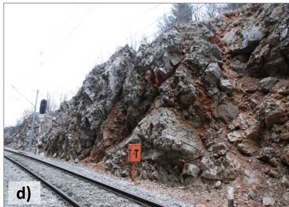
Slika 5-13. Procjena parametra Razvedenost : a) klasa I (604, 95-D); b) klasa II (604, 19-D); c) klasa III (502-19-D); d) klasa IV (202-59-L)
