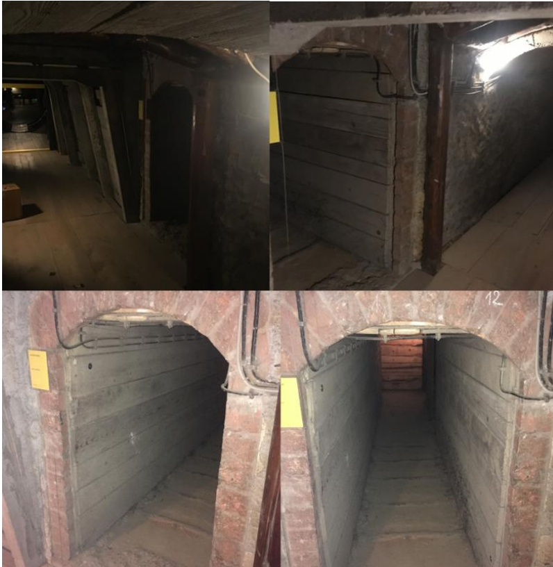
Slika 5-11. Prolaz s najmanjim mjerenim površinskim presjekom u podzemnim prostorijama Tehničkog muzeja, u Zagrebu.
