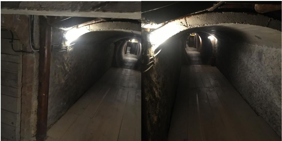
Slika 5-13. Prolaz s površinskim presjekom trapeznog oblika u podzemnim prostorijama Tehničkog muzeja, u Zagrebu.
