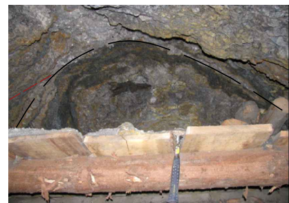
Kontaktna zona/rasjedi strop, 12 m
