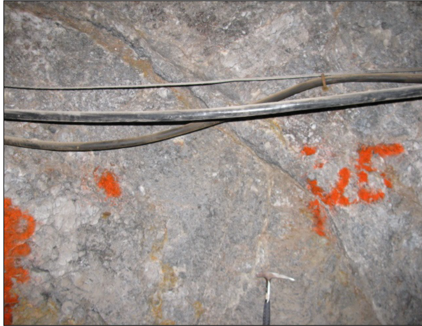
Slika 5.14. Brečirani dolomit, mlađi rasjed, drugi segment, lijevi bok, 25 m
