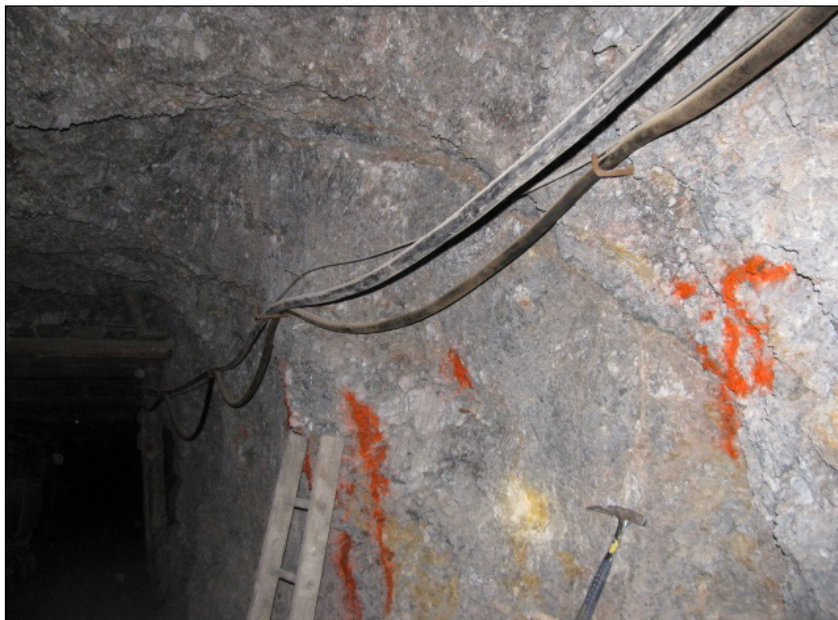
Slika 5.14. Brečirani dolomit, mlađi rasjed, drugi segment, lijevi bok, 25 m
