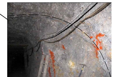
Brečirani dolomit, mlađi rasjed, bok i strop, 25-30 m
