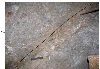
Brečirani dolomit, stariji rasjed, desni bok, 27-30 m
