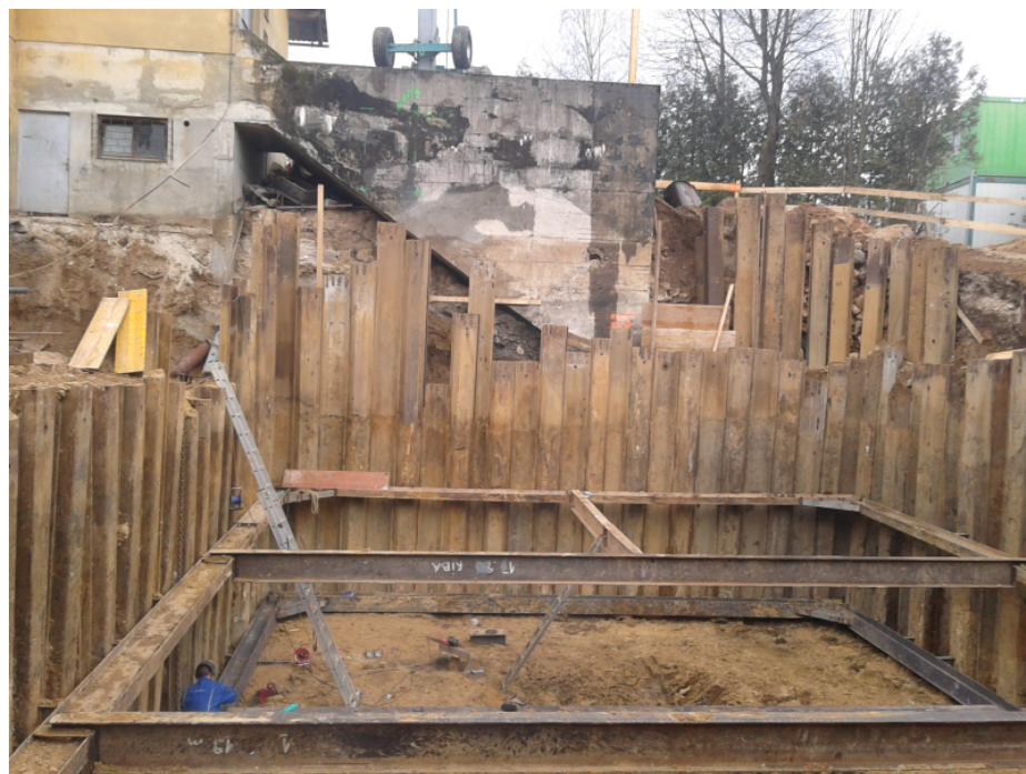
Slika 2-3 Primjer razuprte građevne jame ( http://www.irgo.si )
