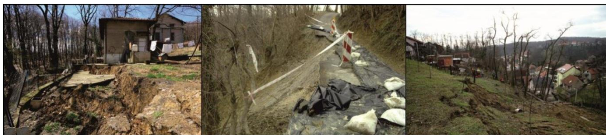
Slika 2.8 Klizišta koja su ugrozila ili uništila kuću ili prometnicu u razdoblju zime i proljeća 2013. godine (Bernat i dr. 2014)
