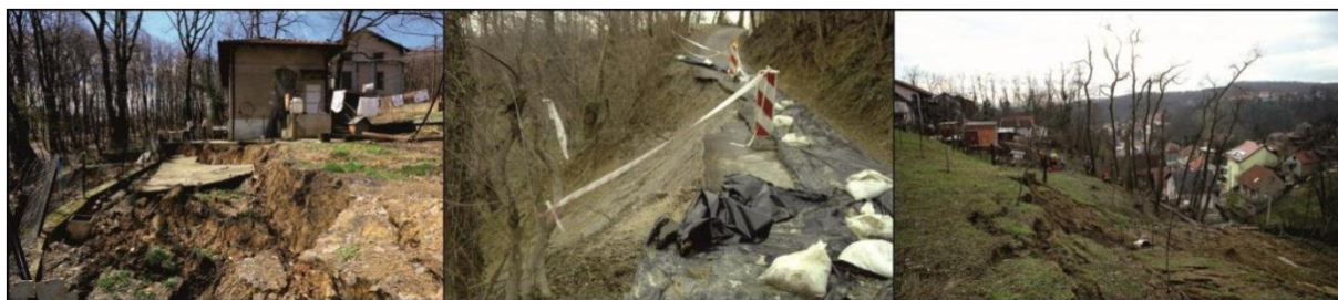
Slika 2.8 Klizišta koja su ugrozila ili uništila kuću ili prometnice u razdoblju zime i proljeća 2013. godine (Bernat i dr. 2014)
