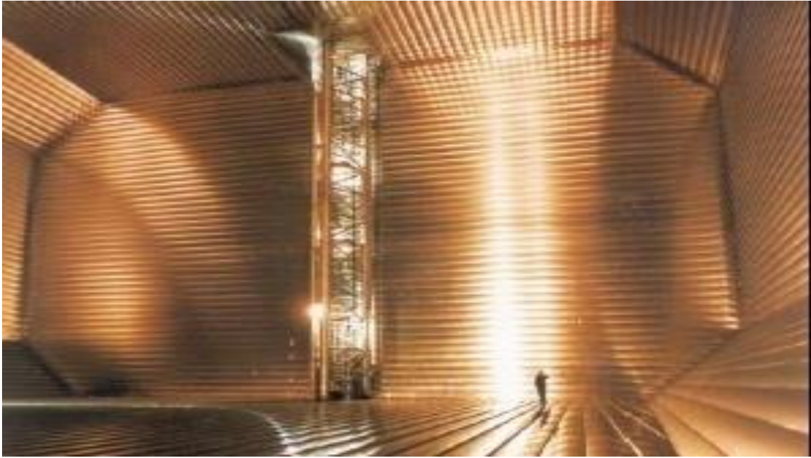
Slika 2-7. Membranski spremnik (Hans et al., 2002)
