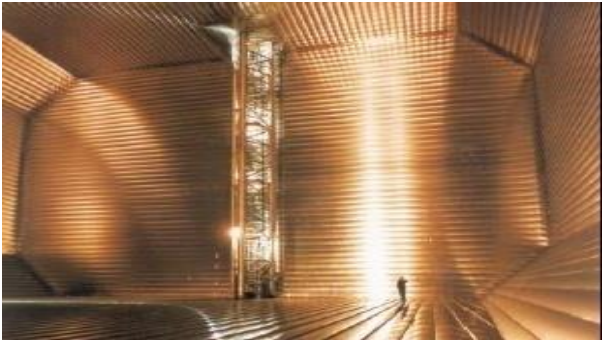
Slika 2-7. Membranski spremnik (Hans et al., 2002)
