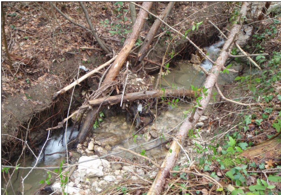
Slika 6-19. Kratki segment drenažnog kanala jaruge s ID brojem 166, kroz koji teče voda potoka Kučina.
