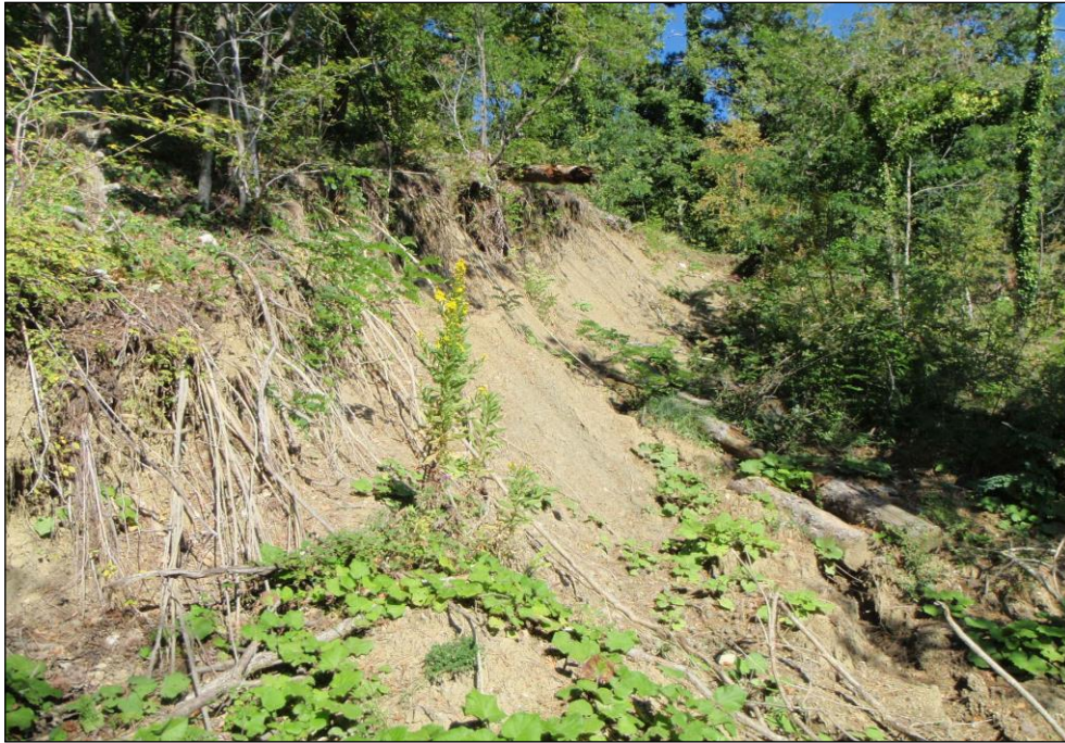
Slika 6-33. Čeona pukotina klizišta s ID brojem 34. U nožici pukotine je iz koluvija uzet uzorak koji je na temelju kemijske analize određen kao disperzivan.
