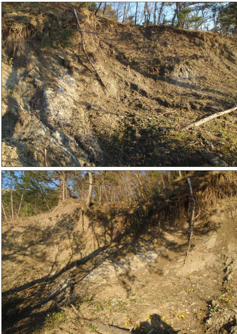
Slika 6-34. Čeona pukotina klizišta s ID brojem 28. Na pukotini su registrirani tragovi kristalizacije tenardita na dubini od oko 1 m do 2,5 m koji nedvojbeno potvrđuju postojanje disperzivnih materijala i na većim dubinama od onih koje su uzorkovane.
