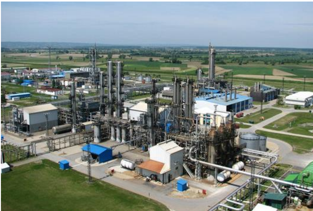
Slika 4.5. Centralna plinska stanica Molve (izvor: www.energetika-net.com , 2015)
