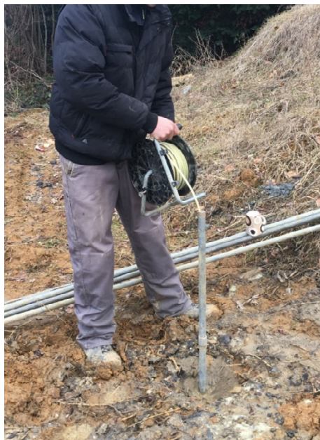
Slika 3.3 Mjerenje razine podzemne vode u bušotini B-3.
