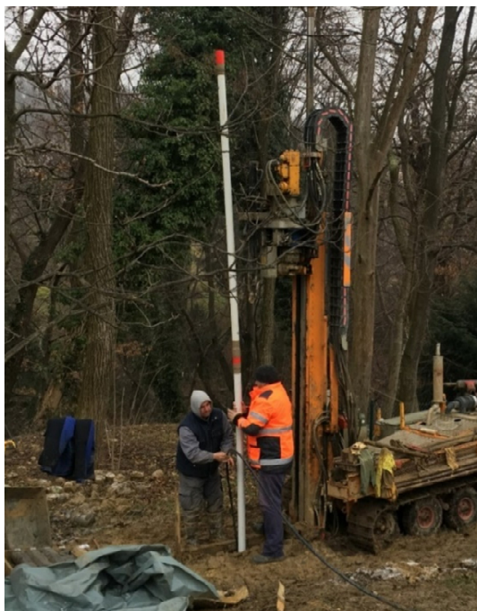
Slika 3.4 Ugradnja inklinometra u bušotinu B-4.
