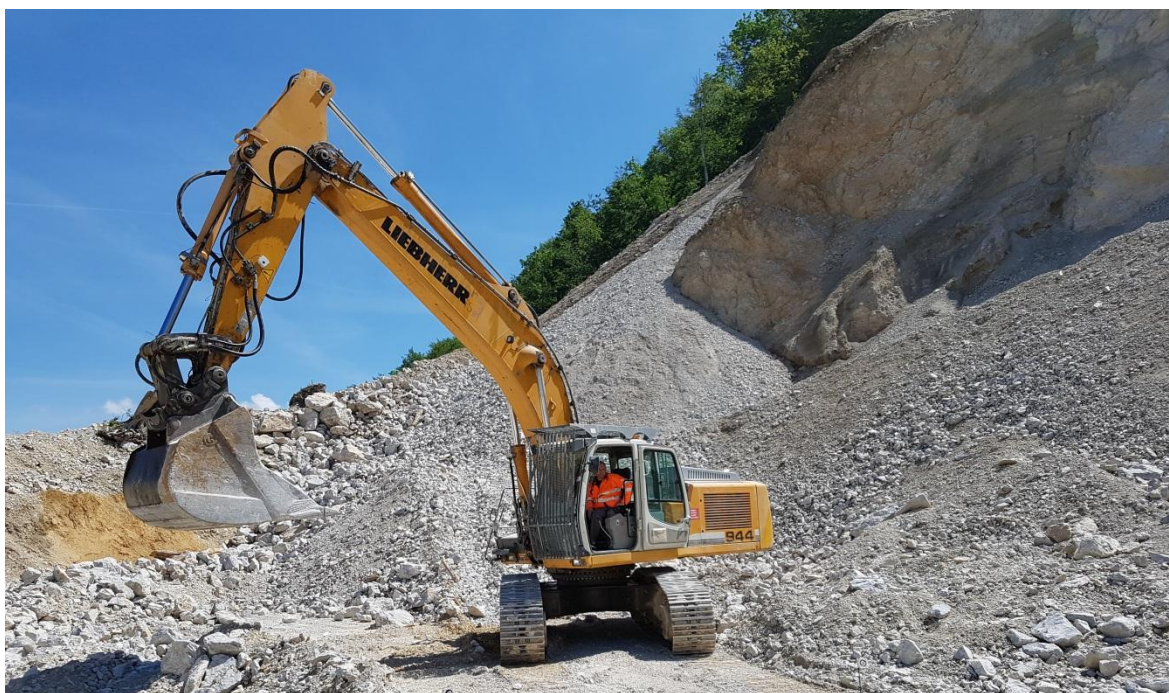
Slika 7-1. Stroj na kojem je mjereno
